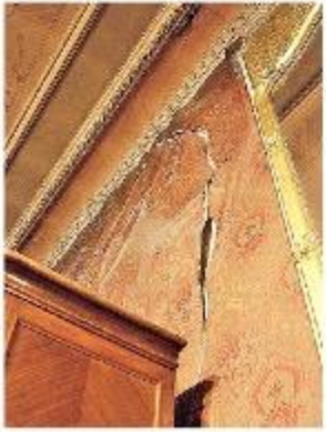
Algunas de las grietas que presenta la estructura del Palacio Braun Menéndez.
