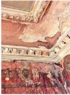
Algunas de las grietas que presenta la estructura del Palacio Braun Menéndez.
